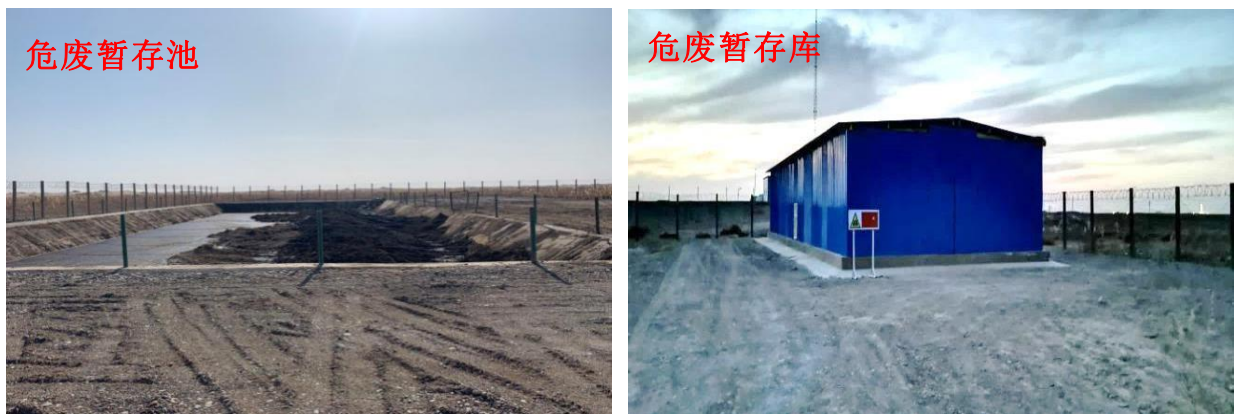
图 3.1-3 危废暂存池、危废暂存库现场照片
